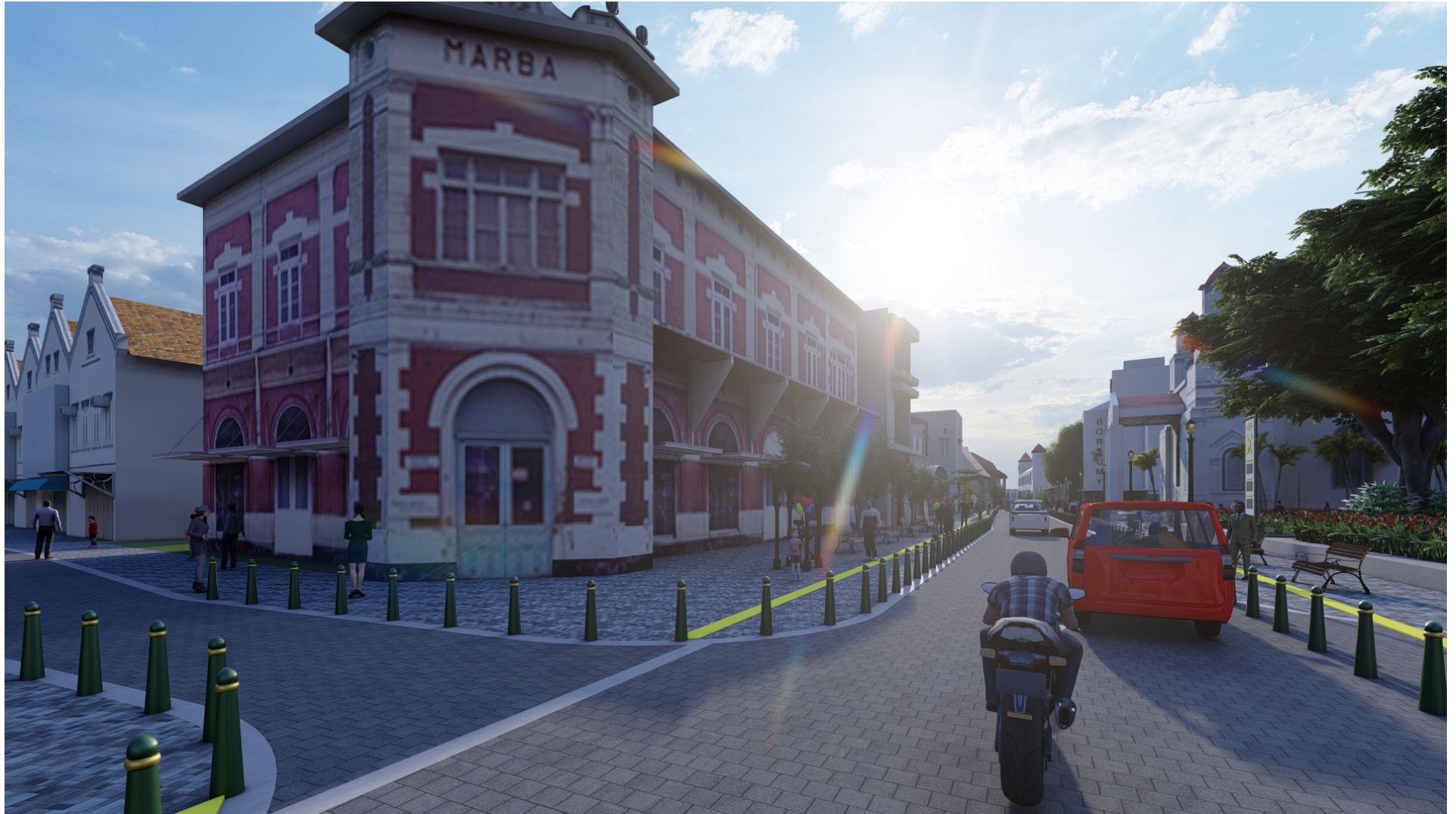
Gambar 2. 24 Tampak Depan Gedung Marba
