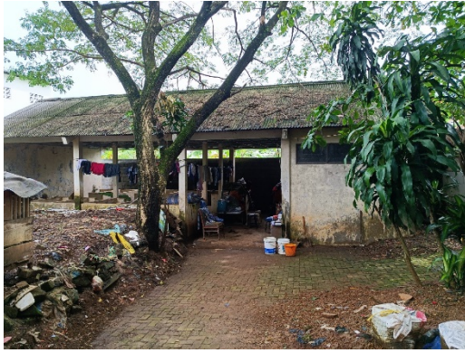
Bagian Depan Bangunan TPS 3R Tembalang
