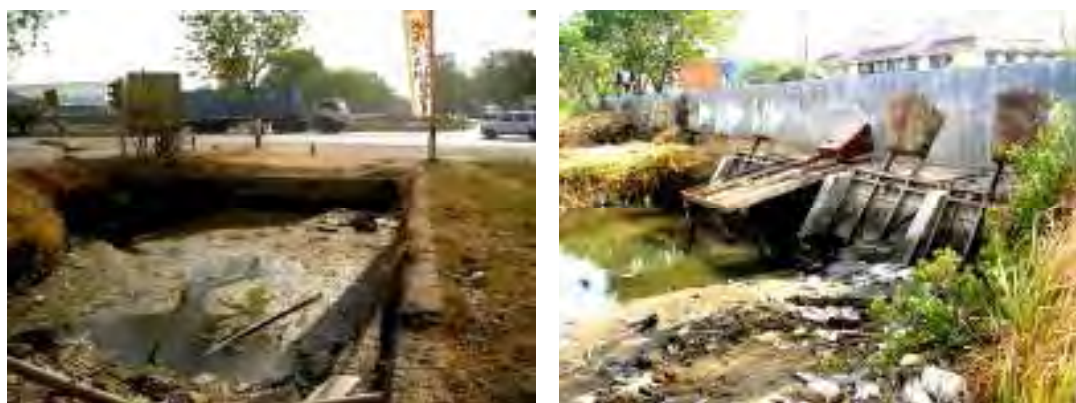
Gambar 3-5 Kegiatan O & P yang tidak memadai berdampak pada kinerja sistem drainase yang rendah
