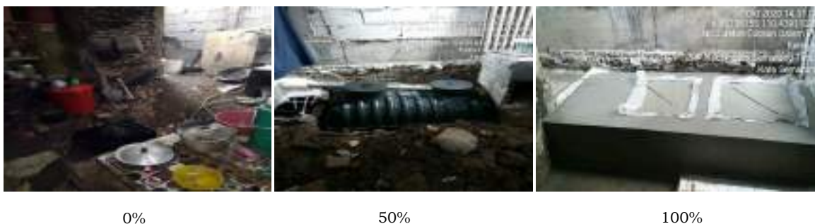
Gambar 3. 4 Kegiatan Infrastruktur Sanitasi, Pembangunan Tangki Septik Kel. Kemijen Jl. Cilosari Dalam Kelurahan Kemijen
