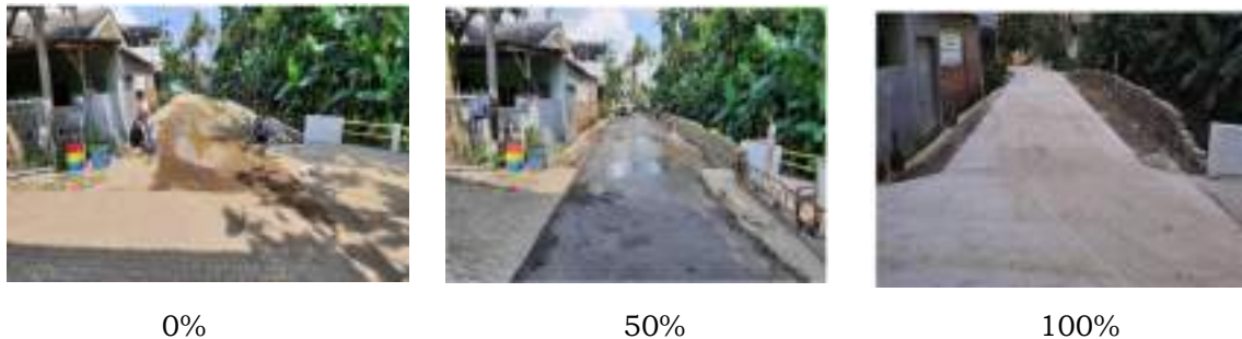
Gambar 3. 2 Kegiatan Peningkatan dan Penanganan Sarpras Lingkungan Permukiman, Betonisasi Jl. Tanjung Sari Kelurahan Pedurungan Lor Kecamatan Pedurungan
